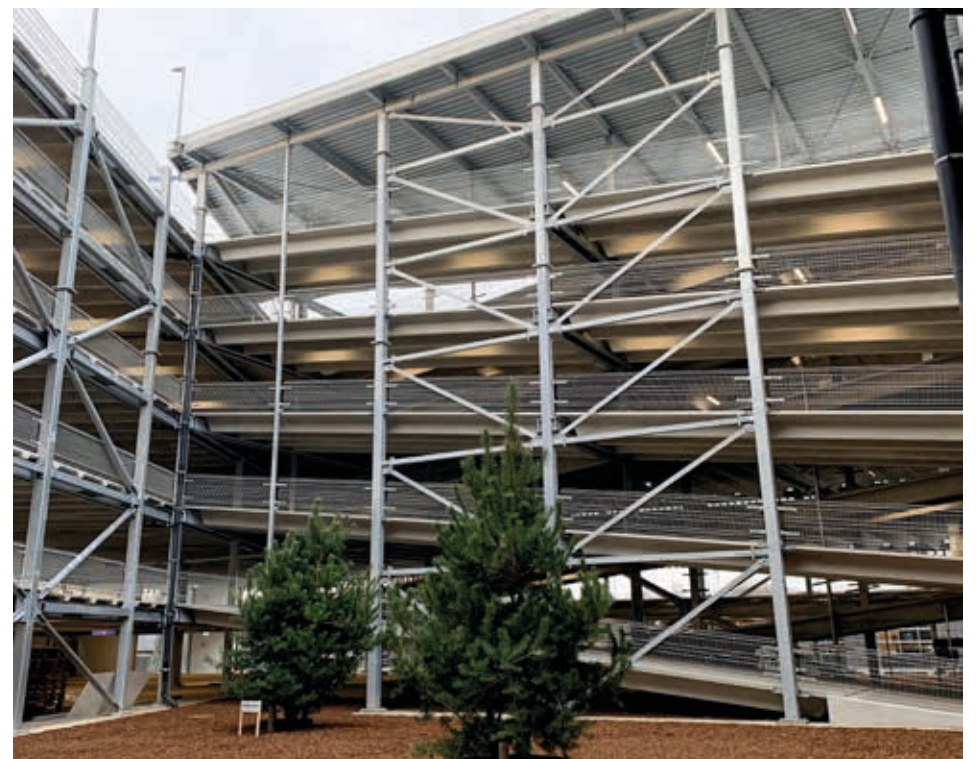
Foto: Ballast Nedam PMC Specialties
