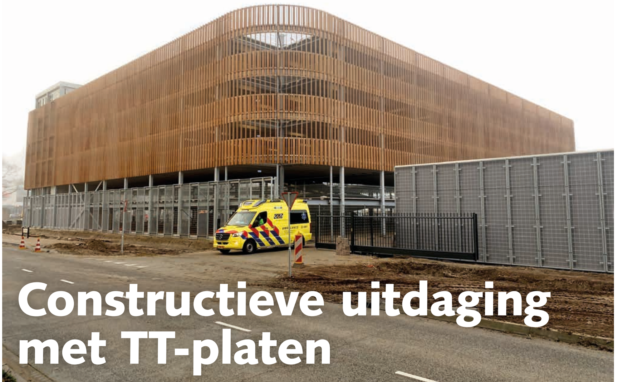
Foto: Ballast Nedam PMC Specialties
